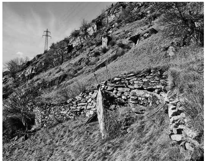
Teil der Wehr- mauer zur Siedlung «Im Gstepf».
