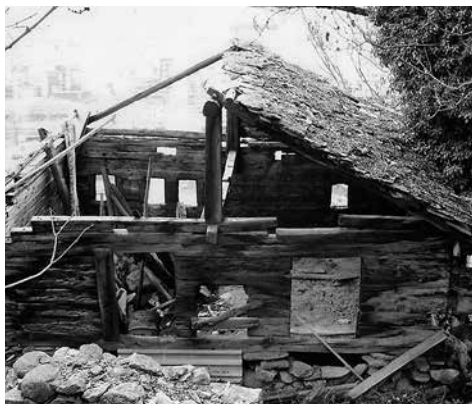
Abstellraum mit Schlupfloch zum Unterbau.
