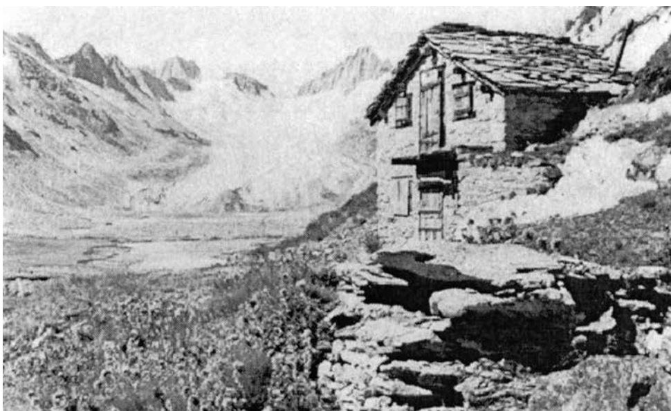
Hütte für die Hirten im Obergeschoss ab 1925, im Untergeschoss Eingang zum Tunnel, der einem Teil der Herde als Schutz vor der Witterung diente. Heute unter Wasser
