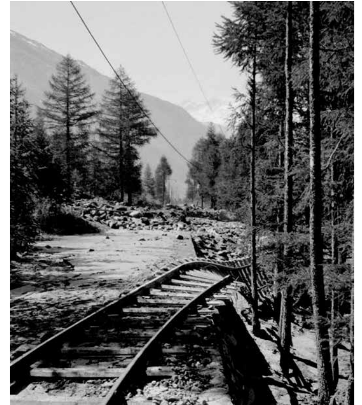
Zerstörung der Bahnlinie der BVZ beim Murgang von 1947
