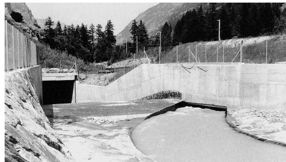
Tunneleingang im «Bongässi»
