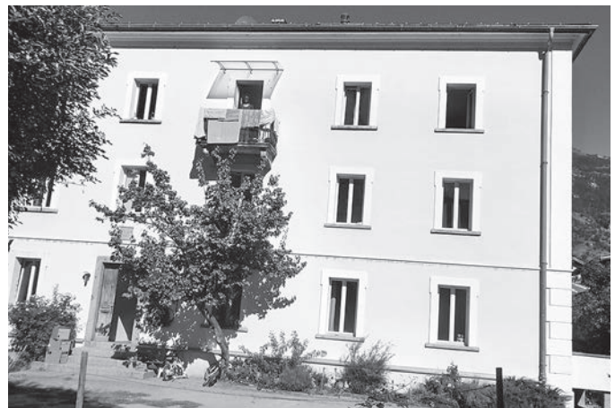
Das stattliche, renovierte, dreistöckige Oggier-Haus im «Gibiww» in Turtmann
