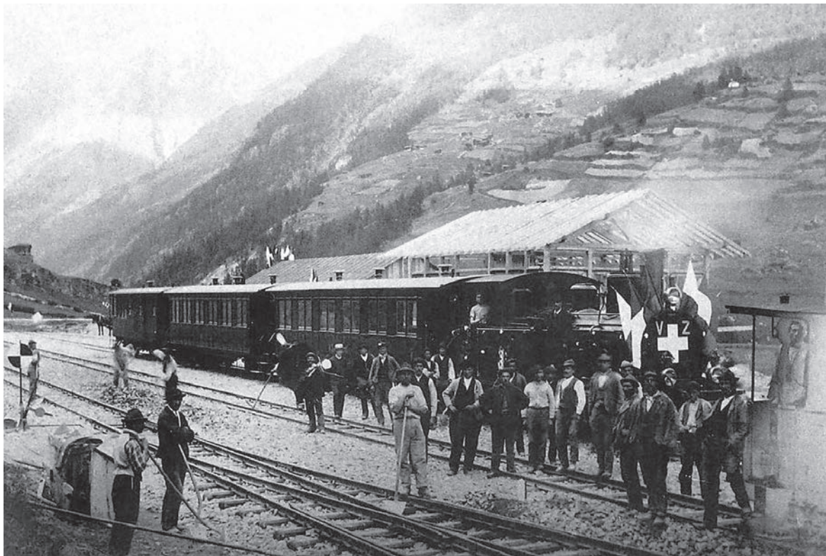
1891: Erster Zug im noch unvollendeten Bahnhof Zermatt. Man arbeitete mit Schaufeln...
