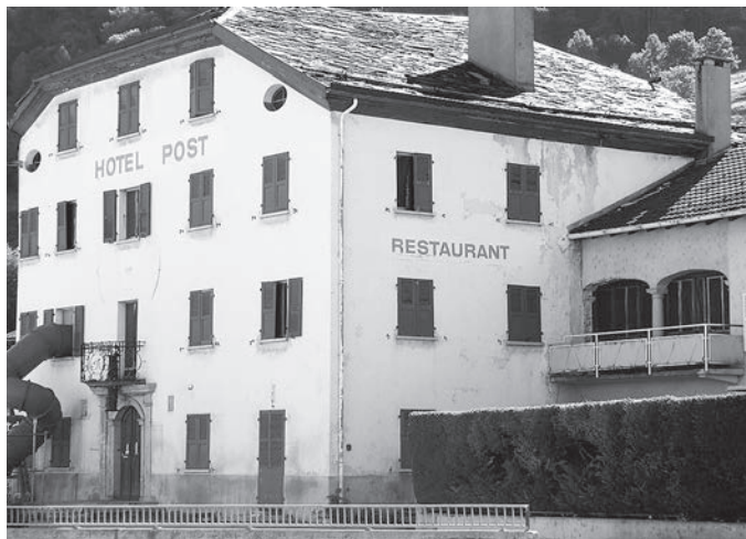
Hotel La Poste in Turtmann, das nun saniert werden soll
